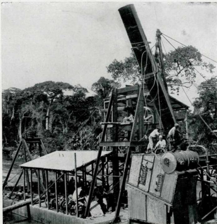
Fig. 51. — COMPAGNIE AUXILIAIRE GOLDFIELDS ASHANTI. — Installation pour le dragage de l'or de 2 Chaudières **Babcock et Wilcox**, à réservoir d'eau et de vapeur composé de plusieurs parties à assembler sur place et de 2 cheminées transportables : Système **Babcock et Wilcox**.
